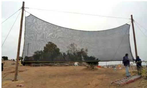
Figura 23. Etapa de tensado de la malla Raschel, previo a la postura de la canaleta que recoge el agua de niebla y de lluvia.
