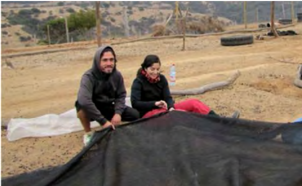
Figura 16. Trabajo de unión de los bordes de la malla Raschel a la manguera que contiene el alambre acerado.
