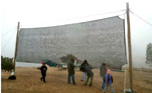
Figura 26. Instalación de la canaleta, para la captación de agua.
