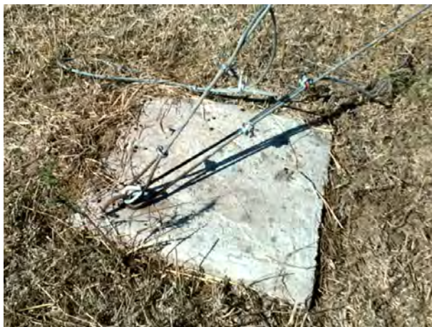
Figura 9. Base de concreto, para anclar los tensores de la estructura "Atrapanieblas". Centro Experimental Hidango, INIA. Comuna de Litueche, Región de O'Higgins.
