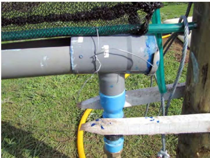
Figura 28. Instalación del sistema de conexión a canaleta captadora de aguas y al estanque de acumulación.
